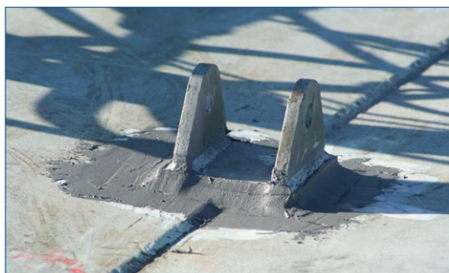
Крепление для антенны приклеено с помощью Belzona 1111
