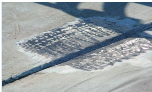
Поверхность подготовлена для нанесения материала Belzona
