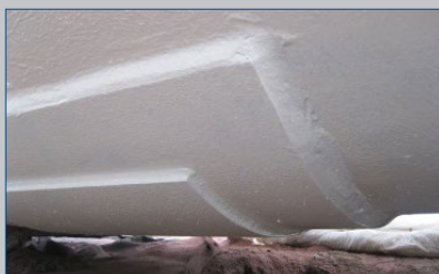
Крепление опорных накладок на трубопроводе
