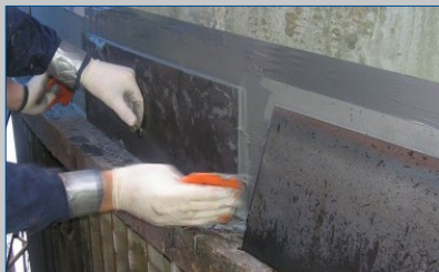
Ремонт сквозных отверстий
