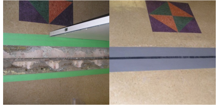
Ремонт разрушенного компенсационного шва в больнице
