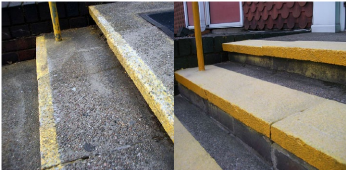
Нанесение системы защиты от скольжения на бетонные ступени
