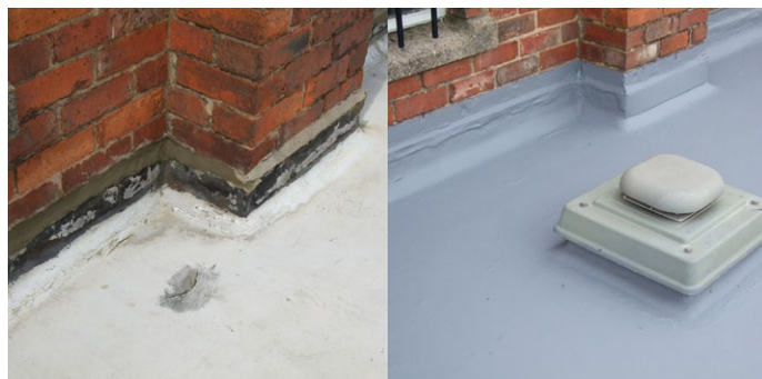
Герметизация шва на стыке крыши/стены
