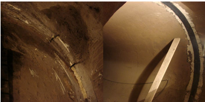
Герметизация швов на подземном трубопроводе
