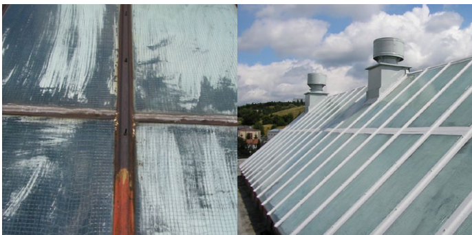
Защита оконных перекрытий
