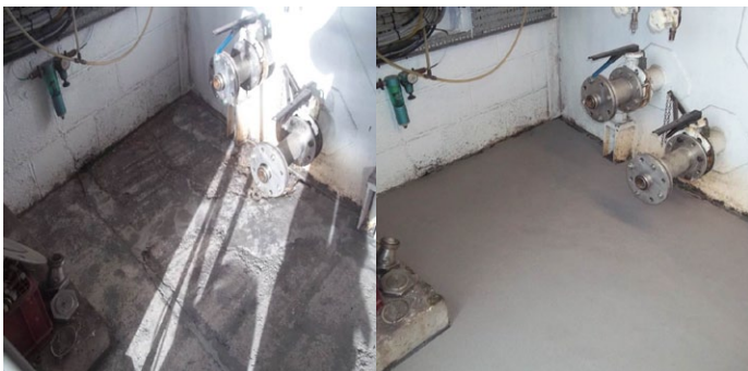
Восстановление покрытия пола
