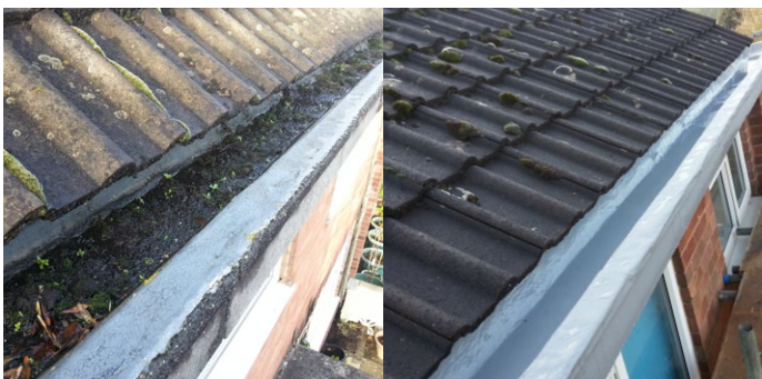
Бесшовная герметизация поврежденного желоба
