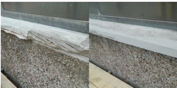
Ремонт отслоившегося бетонного наружного подоконника
