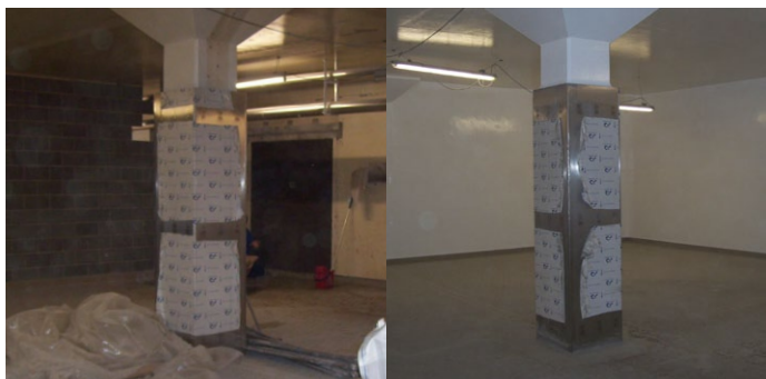
Защита новой кухонной стены с помощью гигиенического покрытия
