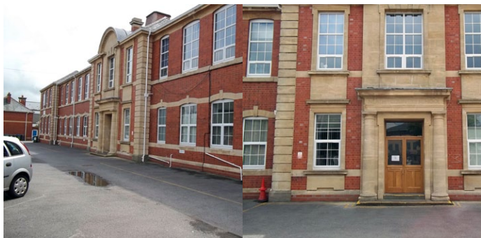
Нанесение прозрачного водоотталкивающего материала на кирпичные и каменные стены
