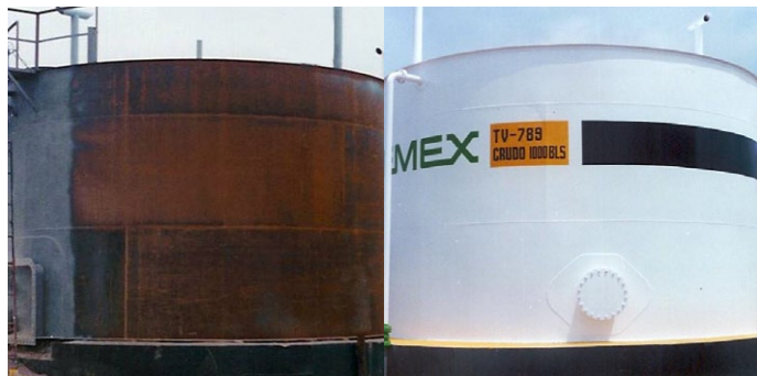
Защита резервуара от внешней коррозии
