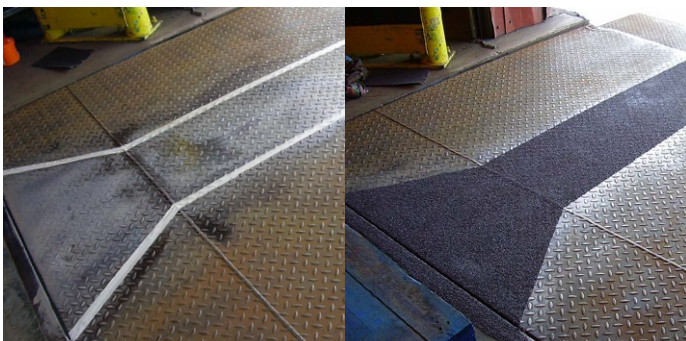
Нанесение системы защиты от скольжения на погрузочную платформу
