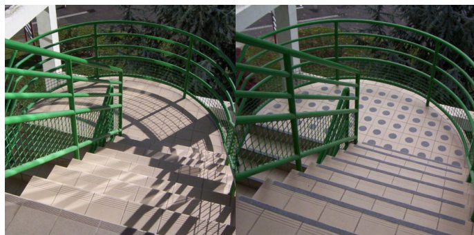
Нанесение противоскользящей системы на лестничную клетку
