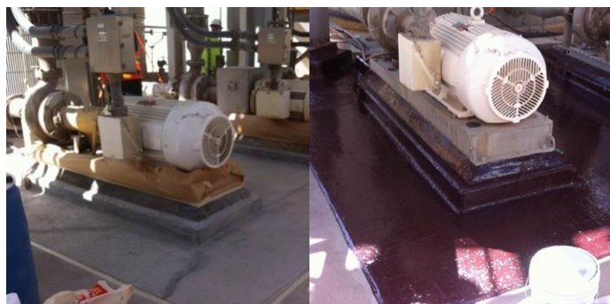
Защита обваловки от воздействия химикатов
