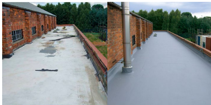
Гидроизоляция крыши с изношенным битумным покрытием
