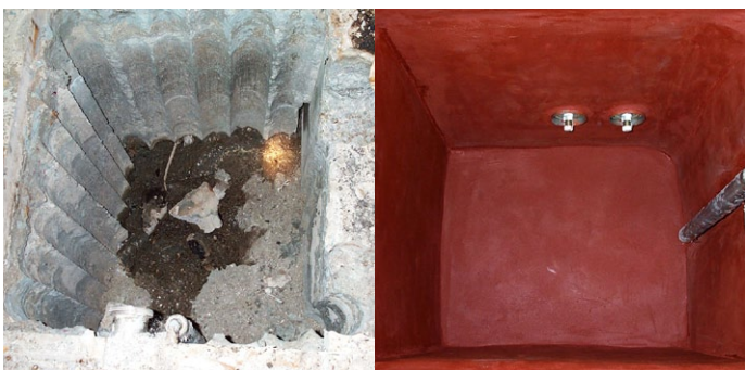
Восстановление поглощающего колодца с помощью химически стойкого материала
