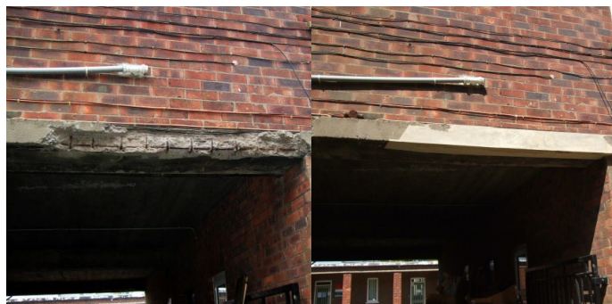
Ремонт навесных перемычек
