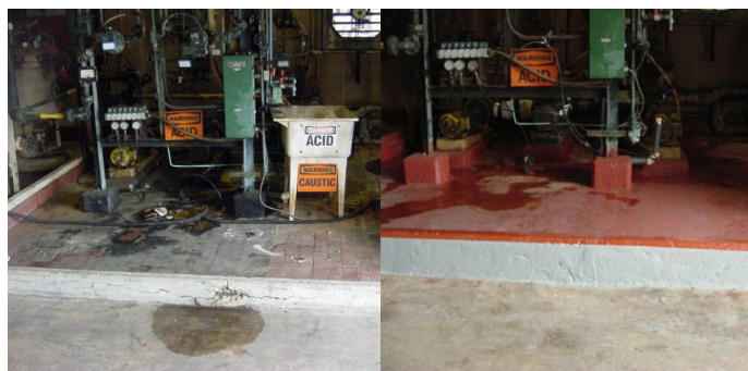
Восстановление покрытия зоны для работы с химикатами
