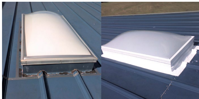
Герметизация стеклянных крыш с помощью гидроизоляционной мембраны
