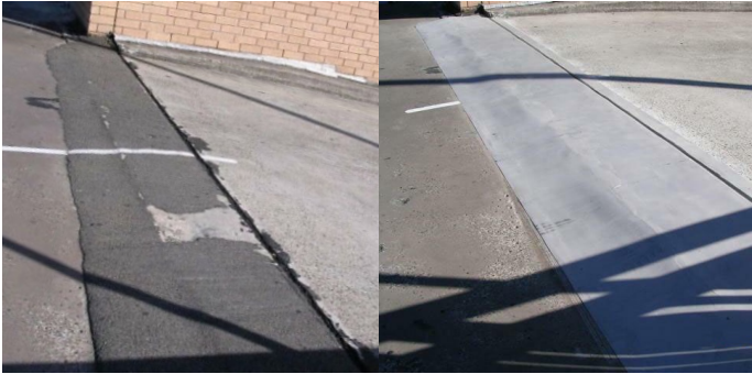
Герметизация компенсационного шва
