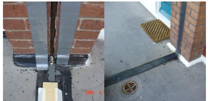
Ремонт протекающего компенсационного шва
