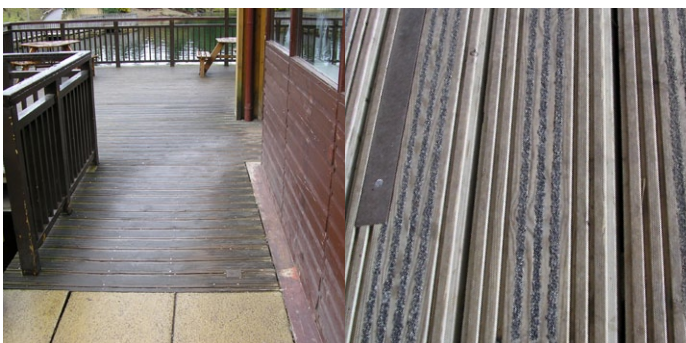
Нанесение системы защиты от скольжения на деревянную террасу
