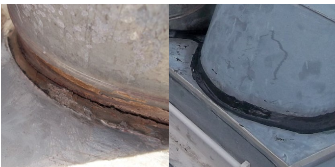
Герметизация изношенных швов теплохладотехники
