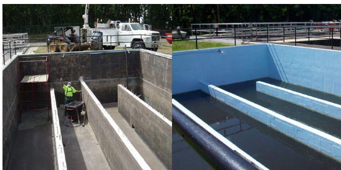
Защита резервуара для хлора от воздействия химикатов
