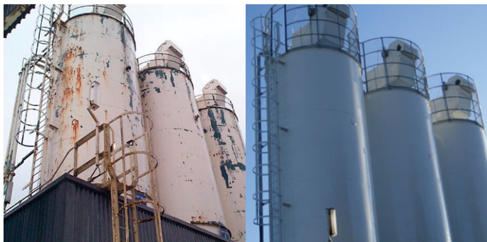
Надежное долгосрочное покрытие сахарных силосных башен
