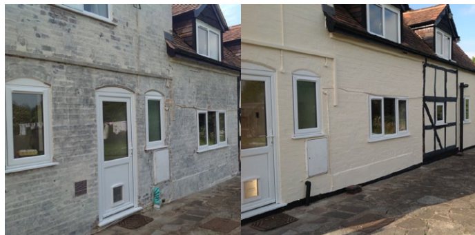
Защита изношенной стены от проникновения воды
