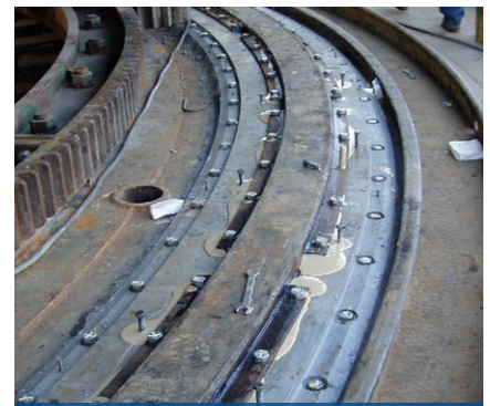
Инжектирование компаунда завершено
