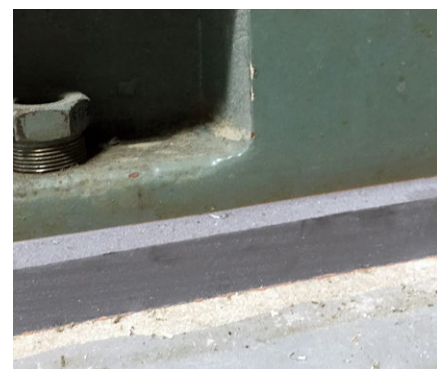
Точная установка оборудования
