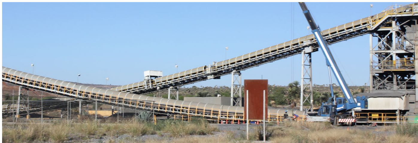
Шина отремонтирована с помощью эластомеров Belzona
