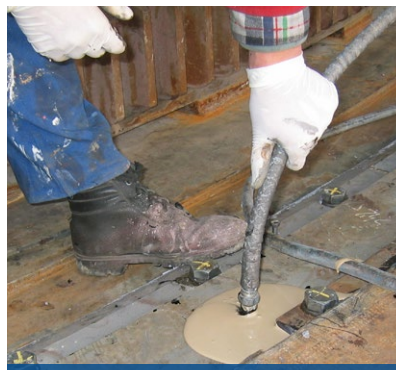
Создание прокладок под опоры поворотного круга экскаватора
