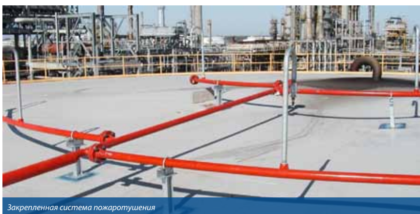
Закрепленная система пожаротушения
