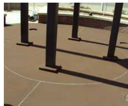
Питтинговые повреждения заполнены и защита нанесена
