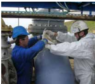
Процесс нанесения обертки
