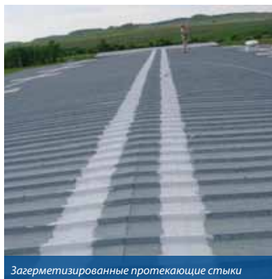
Полная герметизация крыши
