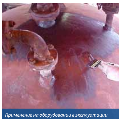
Решение по борьбе с коррозией под изоляцией, применяемое по месту и наносимое на нагретые загрязненные поверхности
