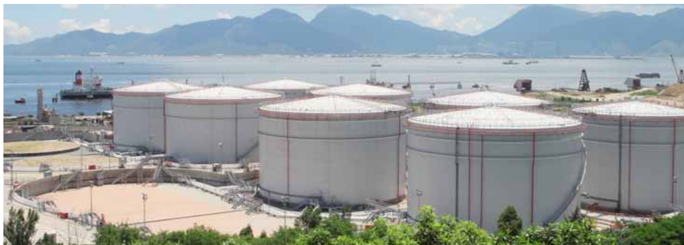
Пластины, приклеенные с помощью материалов Belzona
