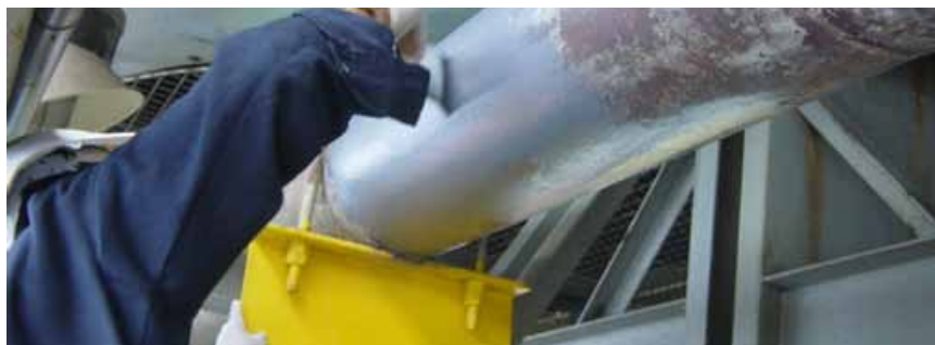
Решение по борьбе с коррозией под изоляцией, применяемое по месту и наносимое на нагретые загрязненные поверхности
