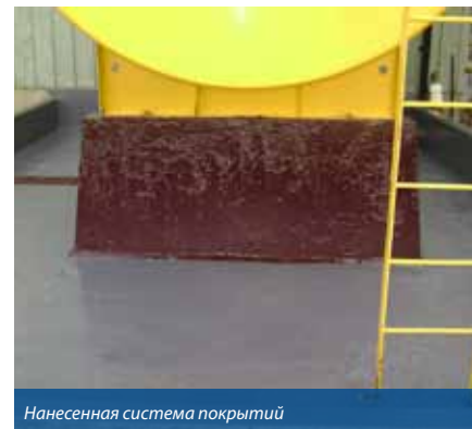
Питтинговые повреждения заполнены и защита нанесена
