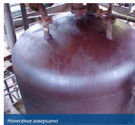
Решение по борьбе с коррозией под изоляцией, применяемое по месту и наносимое на нагретые загрязненные поверхности
