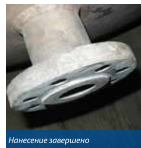
Полное повторное нанесение покрытия
