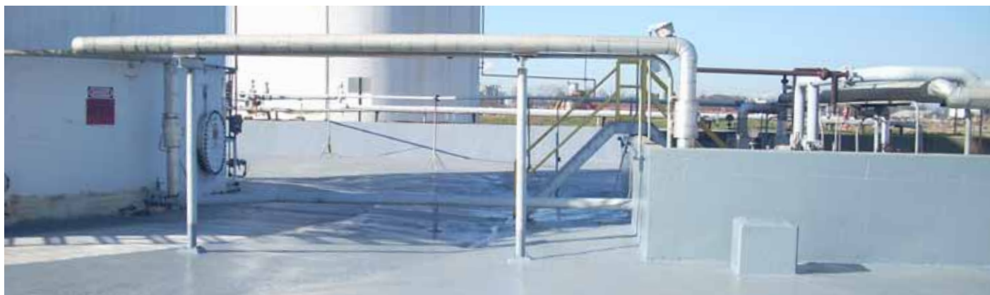
Защищенная зона вторичного обвалования
