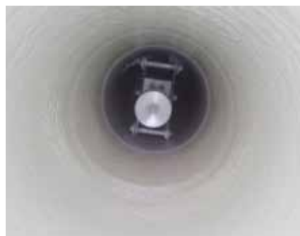
Нанесение покрытия вращательным распылением
