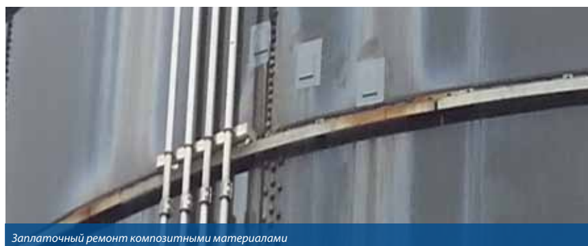
Заплаточный ремонт композитными материалами
