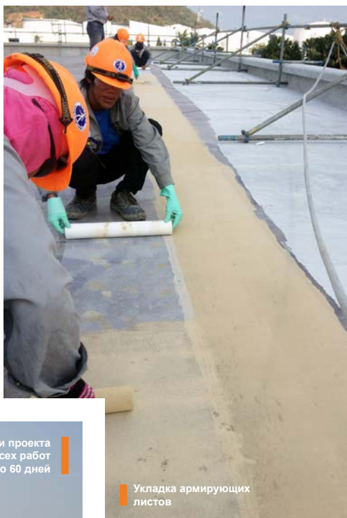
В гидроизоляции нуждались не только старые, но и новые бетонные крыши
