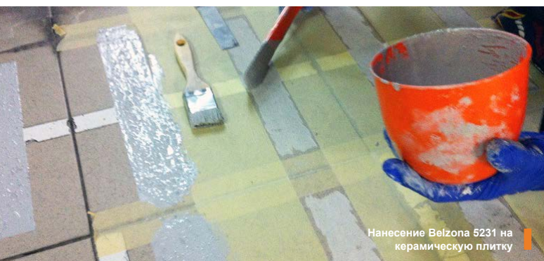
Участки для нанесения покрытия Belzona ограничены маскировочной лентой
