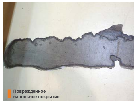
Подготовка поверхности пола к ремонту
