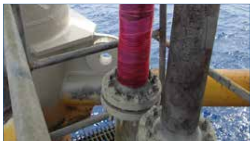
Пленка Belzona 9382 используется для уплотнения ремонтных материалов
