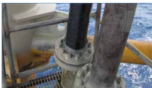
Нанесены четыре витка со смолой Belzona 1982
