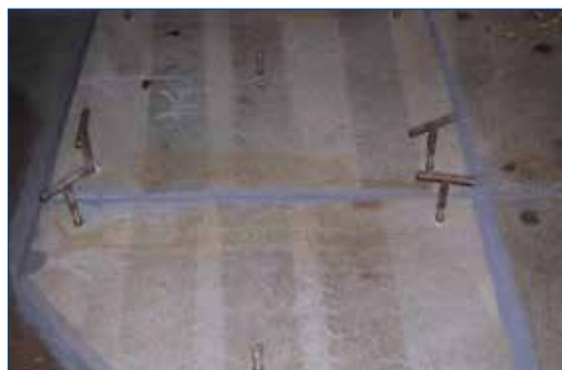
Приклеенные к палубе пластины
