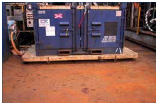
Корродированная палуба платформы
